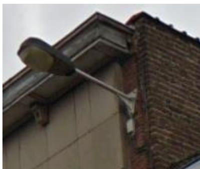
L'éclairage est vétuste et relativement énergivore. Le projet prévoit un renouvellement complet de l'éclairage.
